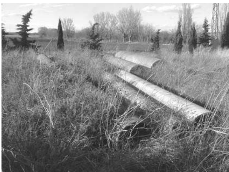
Tuberías fabricadas con fibrocemento abandonadas cerca de los depósitos de la Virgen de la Cabeza. (Tudela, Navarra). 5
